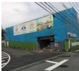
新園舎工事中です！
